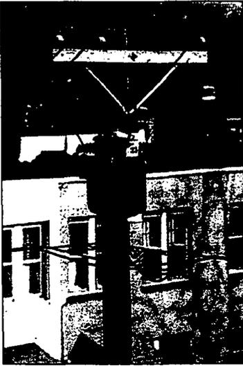
Este transformador reductor cilíndrico baja el voltaje de 4 000 V a 220 V para entregarlo a un grupo de residencias. (George Semple)
